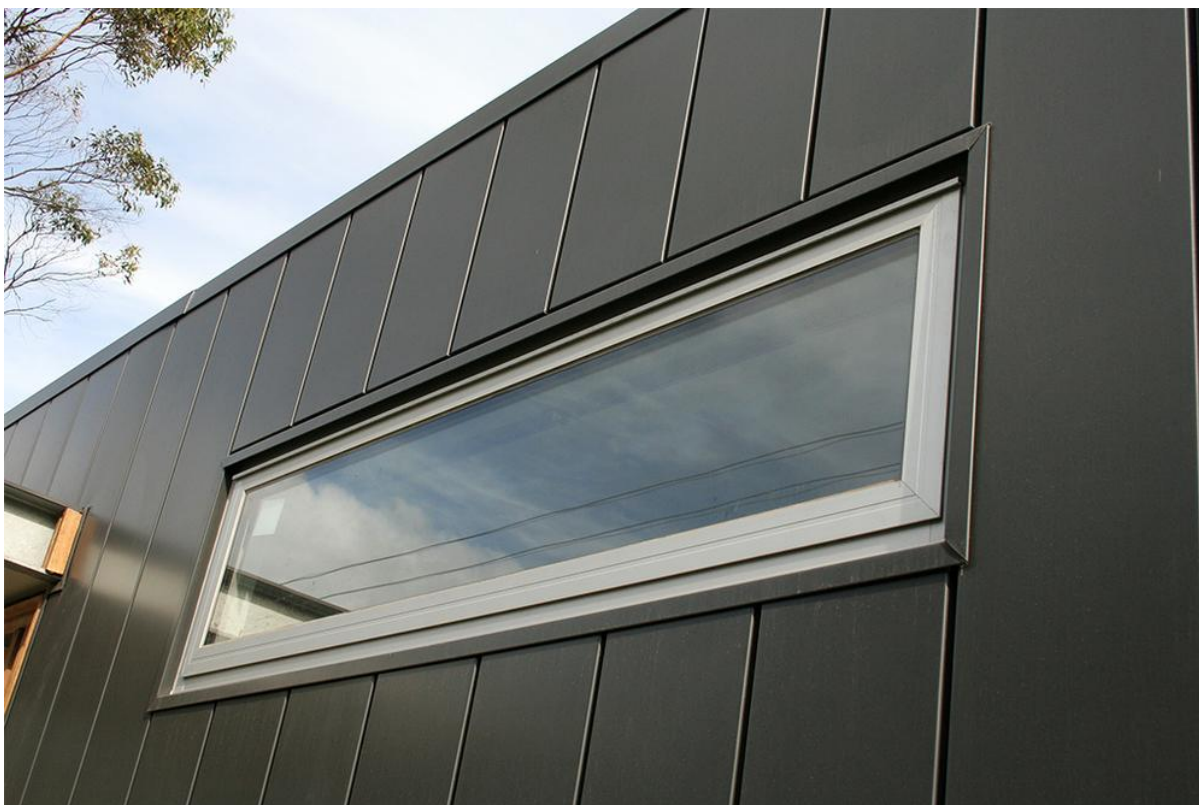
Panel wentylowany (układ pionowy) - otoczenie okien
