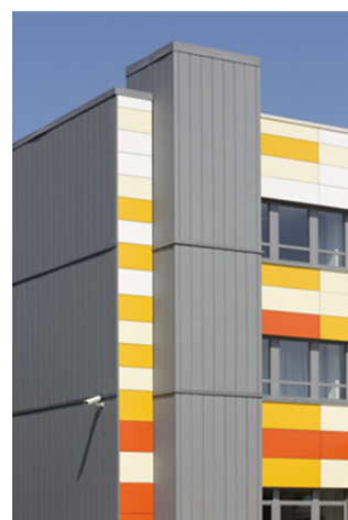
Panel wentylowany (układ pionowy) - narożnik zewnętrzny
